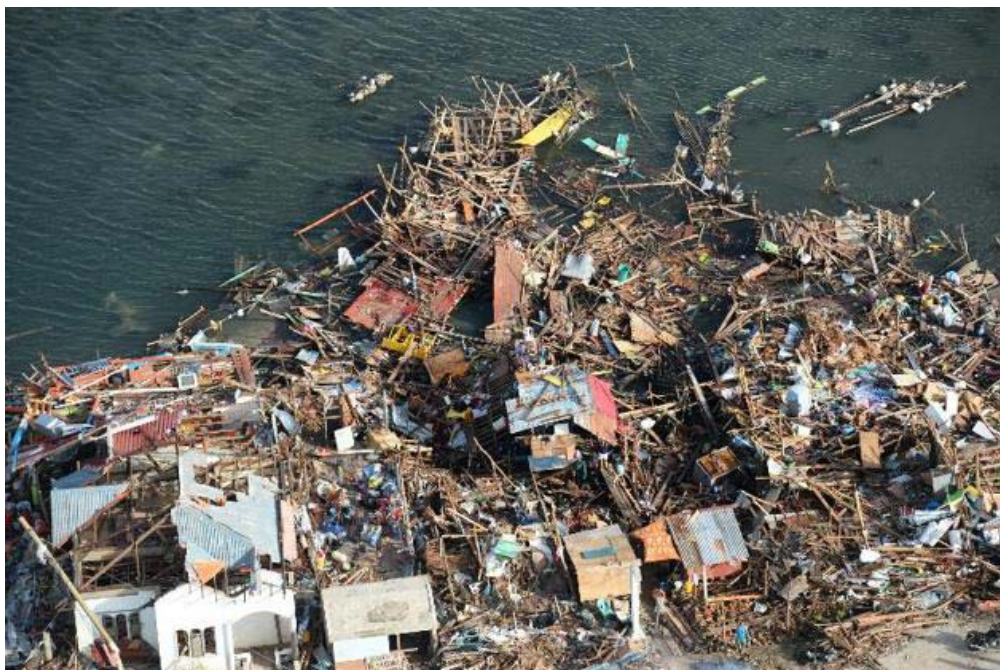
Foto, das die Zerstörung auf Samar durch „Yolanda“ dokumentiert.
